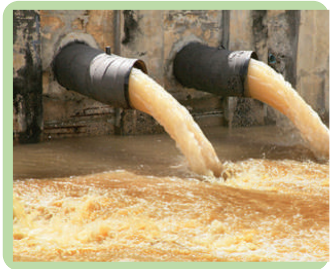
Tratamiento de aguas residuales
